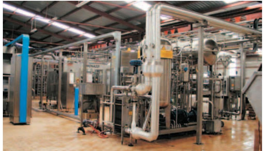
La limpieza y desinfección en sistemas cerrados: circuitos, depósitos, pasterizadores, cubas, etc., requiere productos específicos, con espuma controlada, que actúan por circulación de las disoluciones en régimen de alta turbulencia.
